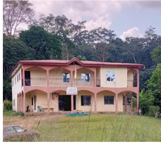
Image 15: Poste de sécurité publique de Mengueme
