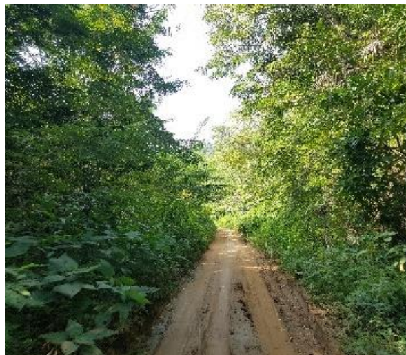
Image 44: Route sans ouvrage de drainage à Minlaba
