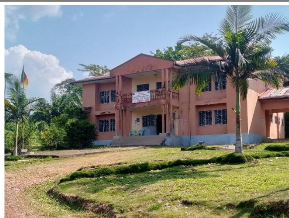
Bâtiment abritant les services de la Mairie
